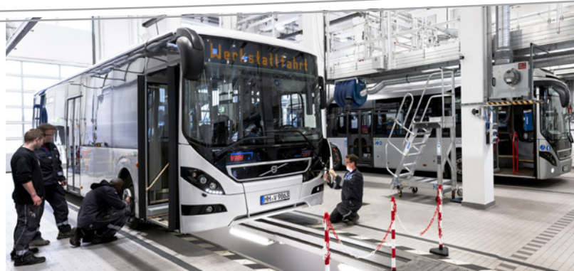
Der 2.700 Quadratmeter große Hallenbau der Elektrobus-Werkstatt hat insgesamt fünf Busspuren und lässt das Arbeiten auf drei Ebenen zu.
