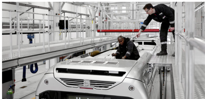
Spezielle Dacharbeitsplätze ermöglichen das sichere Arbeiten an den elektrischen Dachkomponenten der Busse.
