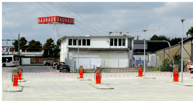
Die ersten 16 Ladepunkte für die Elektrobusse sind auf dem VHH-Betriebshof in Hamburg-Bergedorf installiert.
