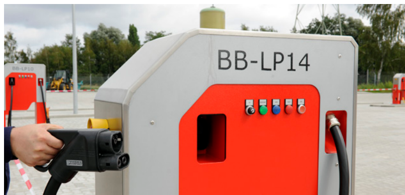
Die E-Busse der VHH werden zum Laden über Combo-2-Stecker an die Wallboxen angeschlossen.
