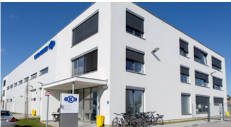
Modernes Trainingszentrum in München-Moosach.
