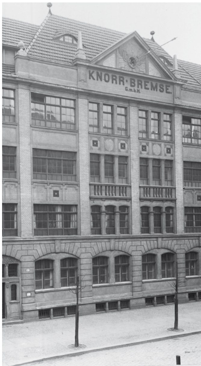
Das Stammhaus in Berlin. In den vier Stockwerken waren die einzelnen Produktionsabschnitte mit Bedacht angeordnet.
